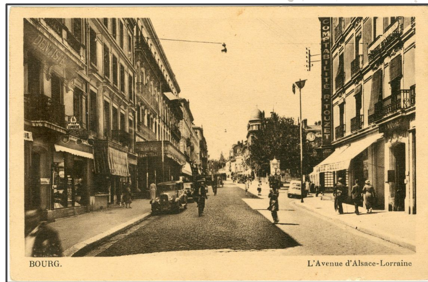
Figure 3 : Avenue Alsace-Lorraine et restaurant Le Français (à gauche) (1940)
